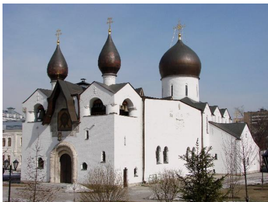
Вид с северо-запада
