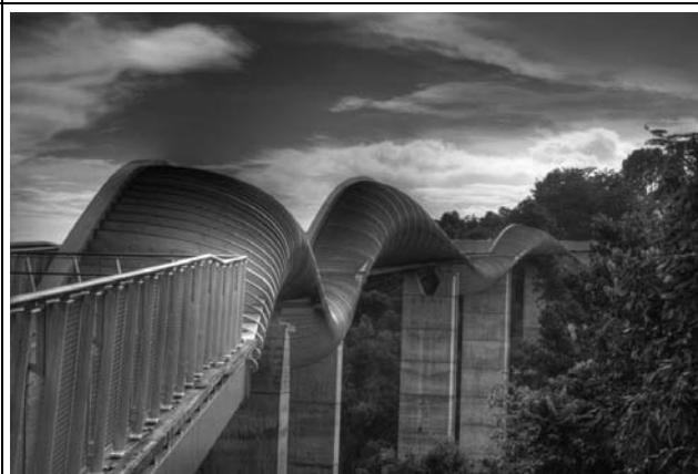
Мост Волны Хендерсона, Сингапур (2008)
